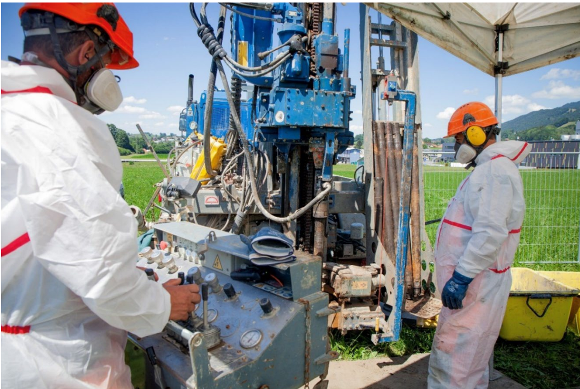
Travaux sur l'ancienne décharge d'En-Craux à Châtel-St-Denis. © Benjamin Ruffieux
