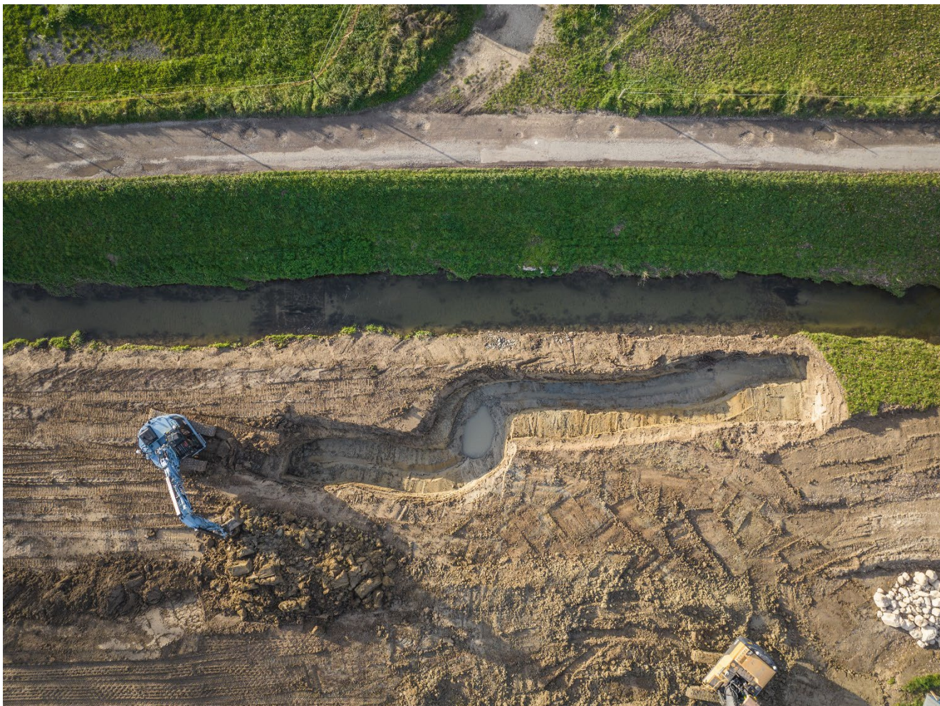
Revitalisation de la Petite Glâne (ouverture du nouveau lit sur le premier tronçon du projet, à Saint-Aubin), 8 novembre 2022. © Upperview Productions
