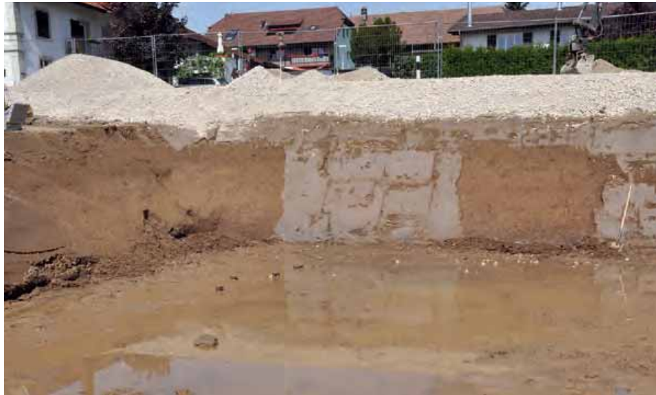
Fig. 25 Saint-Aubin/Sous la Rochetta, vue du site durant le suivi des travaux de 2015
