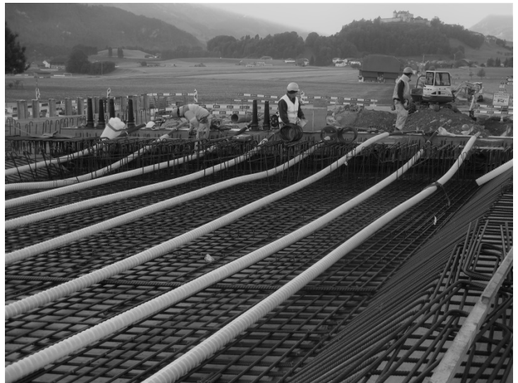
Figure 9 – Reconstruction du pont sur la Trême à Gruyères
