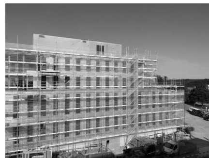
Figure 14 – Bâtiment de police, à Granges-Paccot
