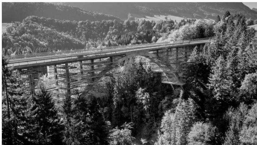
Figure 10 – Assainissement du pont sur le Javro à Crésuz/Val-de-Charmey
