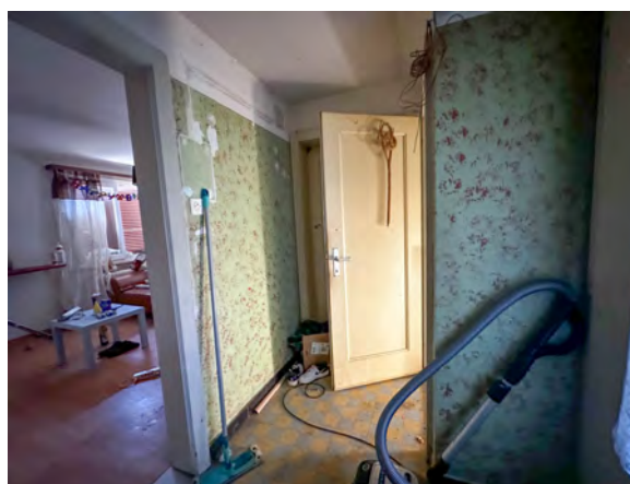
hall du logement au rez
