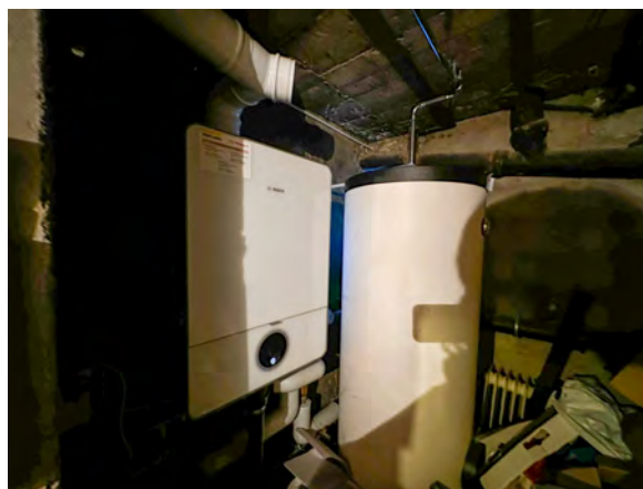
Local chaudière gaz et boiler
