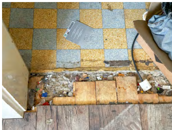
Détail jonction des sols, hall et chambre
