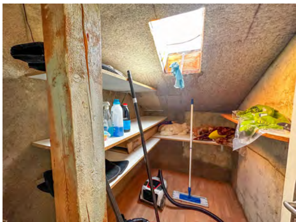
Local rangement sous-pente
