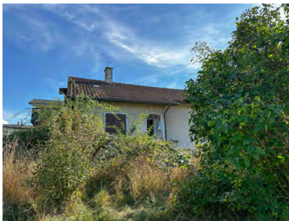
Vue toiture depuis la parcelle voisine
