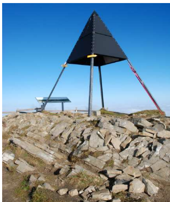
Fig. 3: Pyramide métallique marquant la présence d'un point de triangulation fédérale de 1er ordre installée sur les bancs de grès inclinés du Flysch du Gurnigel, au sommet de la Berra.
