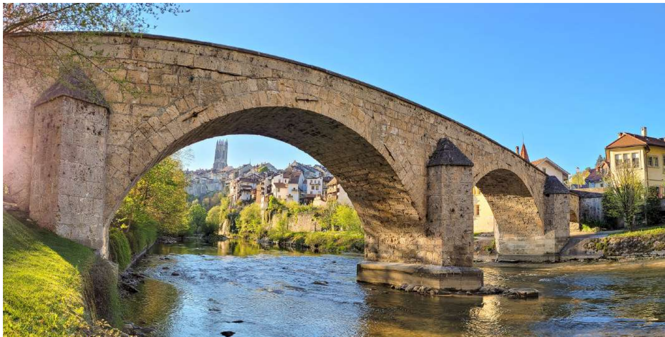
Fig. 5: Construit en 1720 pour remplacer un ancien pont en bois qui reliait le quartier des Planches à celui de l'Auge, le Pont du Milieu est essentiellement constitué de tuf extrait à la Tuffière. Les blocs étaient acheminés jusqu'à Fribourg par bateau sur la Sarine. Lors de la restauration complète de 1973-75, on a utilisé des blocs de tuf provenant de la démolition de l'ancien pont suspendu de la Tuffière, en 1971.
