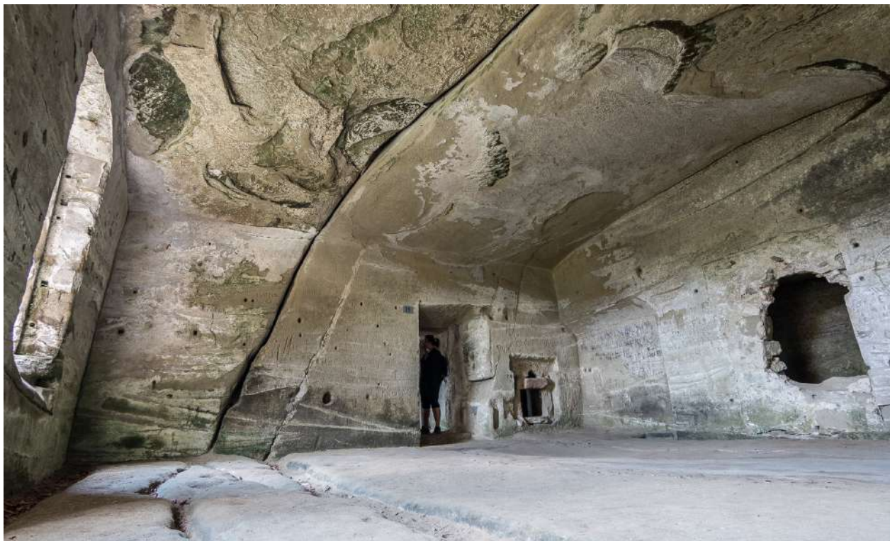
Annexe 1: Particulièrement visible dans la "petite salle", un important système de failles parcourt les grottes de la Madeleine avec une direction dominante parallèle à la façade de l'édifice religieux. Pour sauvegarder le site, d'importants travaux d'assainissement ont été effectués entre 2005 et 2006. Des colonnes en béton armé ainsi que des ancrages s'enfonçant jusqu'à 12 m dans la molasse assurent désormais la stabilité de l'ermitage.
