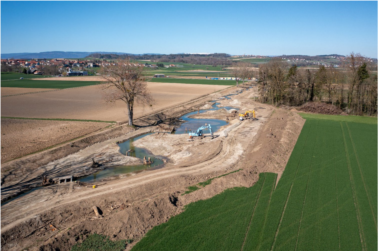
Revitalisation de la Petite Glâne (élargissement conséquent du cours d'eau et talutage du nouveau lit et des berges, à Saint-Aubin), 4 avril 2023. © Upperview Productions
