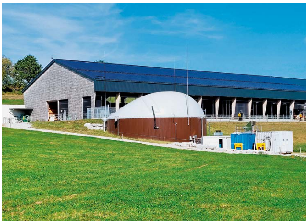
Installation de biogaz devant la Ferme-Ecole de Grangeneuve.
