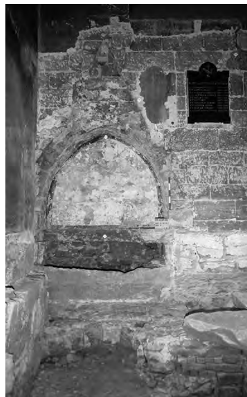
Fig. / Abb. 12 Enfeu du mur nord de la nef au moment de sa découverte Wandnischengrab in der Nordmauer des Schiffs bei der Freilegung
