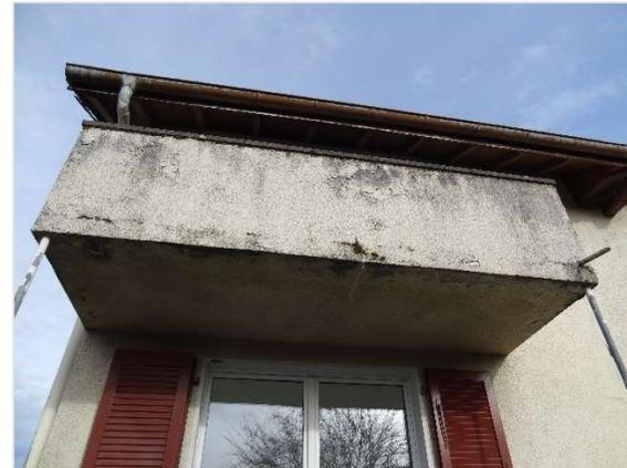
Carbonatation et étanchéité des balcons
