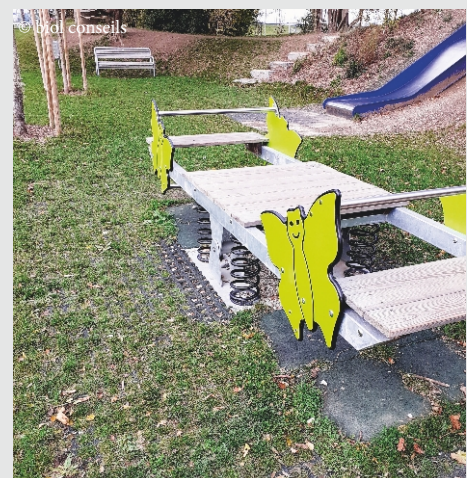
Revêtement végétalisé - Wünnewil-Flamatt (FR)
