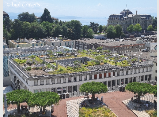
Toiture végétalisée intensive - Lausanne (VD)
