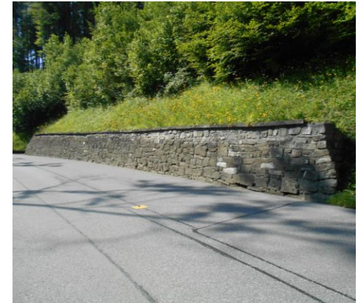
Murs de soutènement
