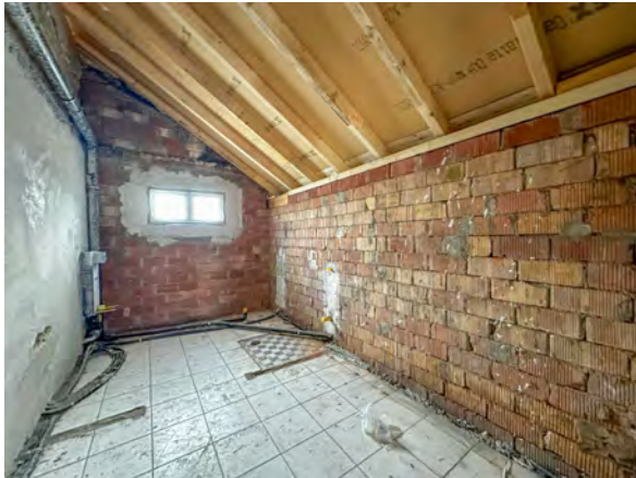
Pièce annexe, sanitaires
