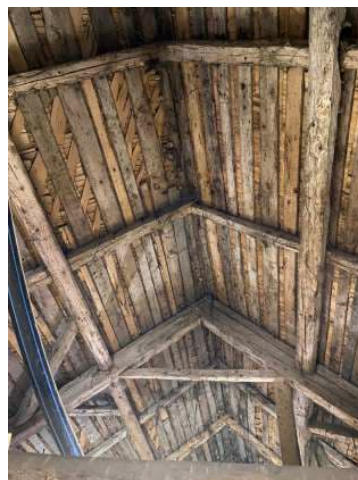
Etat général de la charpente
