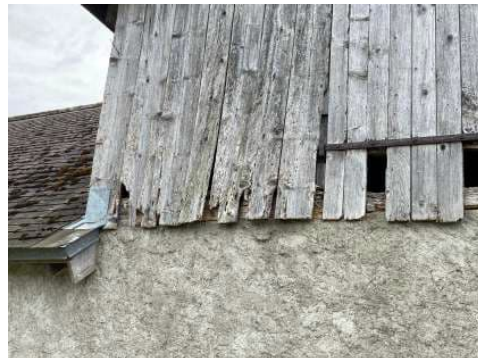
Lames bois pont de grange façade N.O
