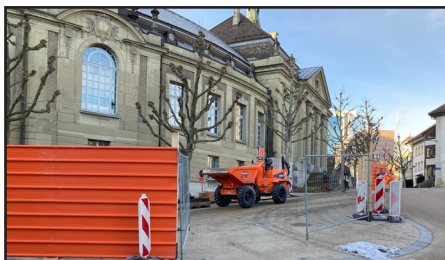
Le bâtiment historique au tout début des travaux en 2021.
