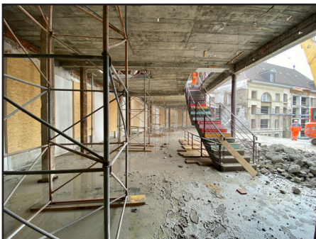
La salle de prêt déconstruite, début 2021.
