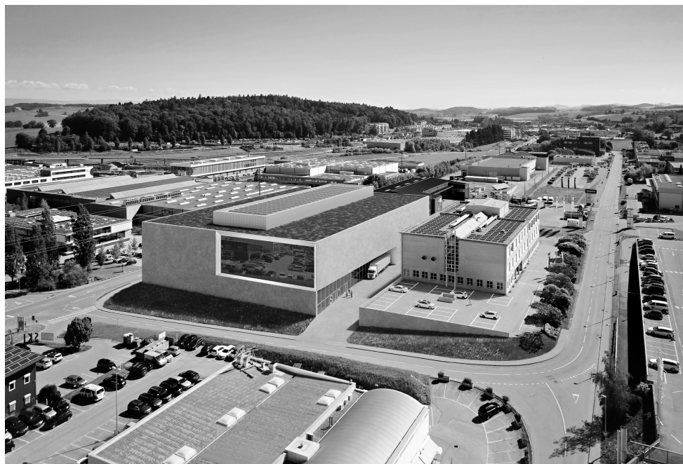
Le centre de stockage est plus sûr et économique. Il comprend 6 niveaux de stockage dont un étage sous-terrain servant d'abri pour la protection des biens culturels. © BAT-MANN
