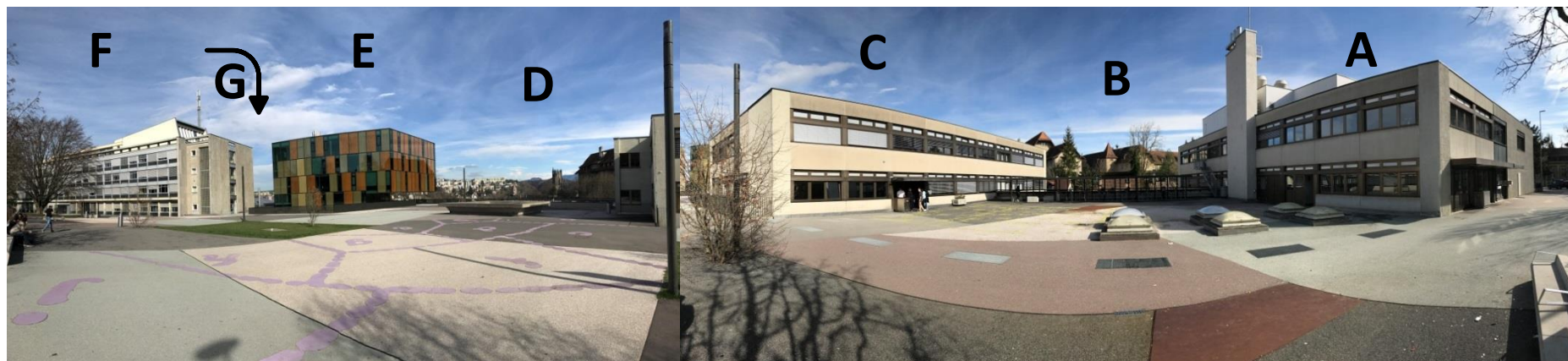
Vue depuis la rue "Derrière-les-Remparts"
