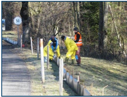
Figure 3 Equipe de montage de la barrière à La Neirigue
