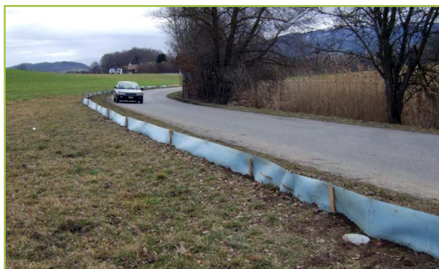
Figure 1 Barrière à batraciens le long de la route communale reliant Magnedens et Posat
