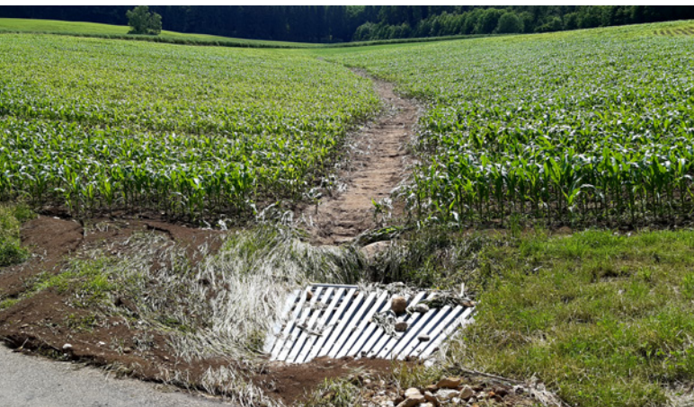
[Figure 3] Erosion de fossé en situation de cuvette – l'eau et le sol érodé s'écoulent au puits à travers la cuvette.
