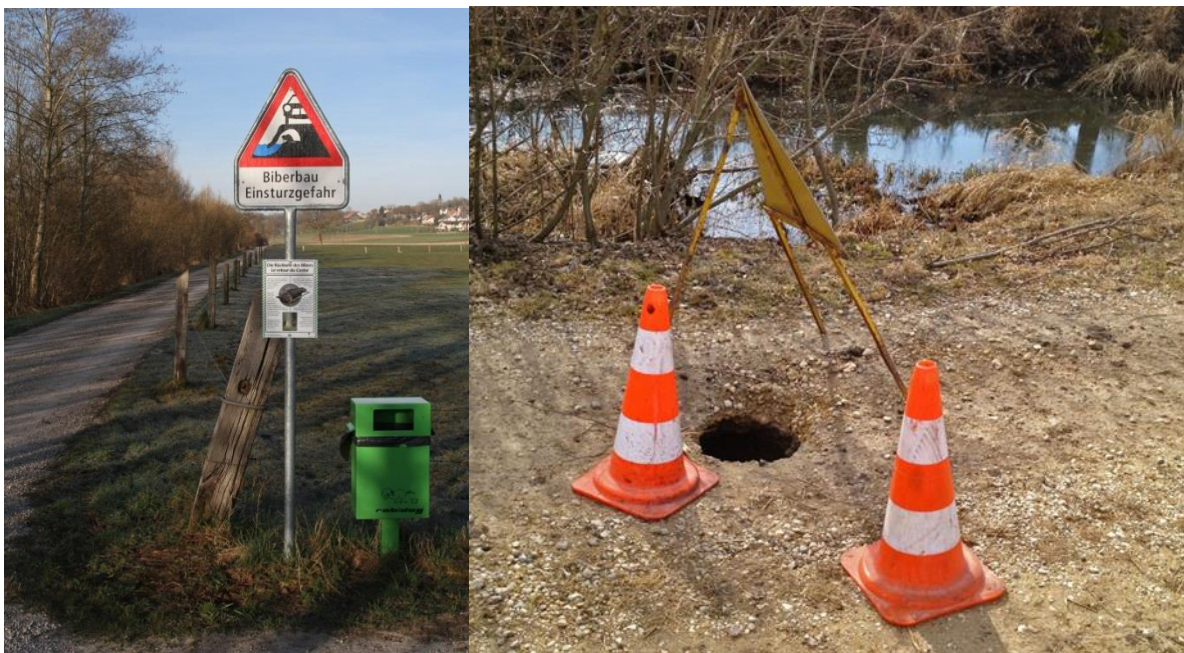
Image 4 : Marquage d'un chemin effondré (photos : SFF, E. Bürgy).
