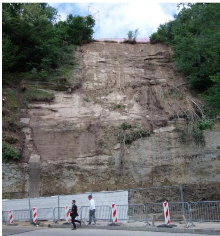
Figure 11 : Glissements spontané et superficiel ayant atteint la route cantonale menant à Bourguillon, au Nord du pont du Gottéron.
