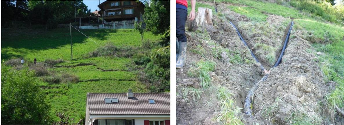
Figure 15 : Mesures préventives prises pour stabiliser un glissement de terrain superficiel dans la région de Flamatt.
