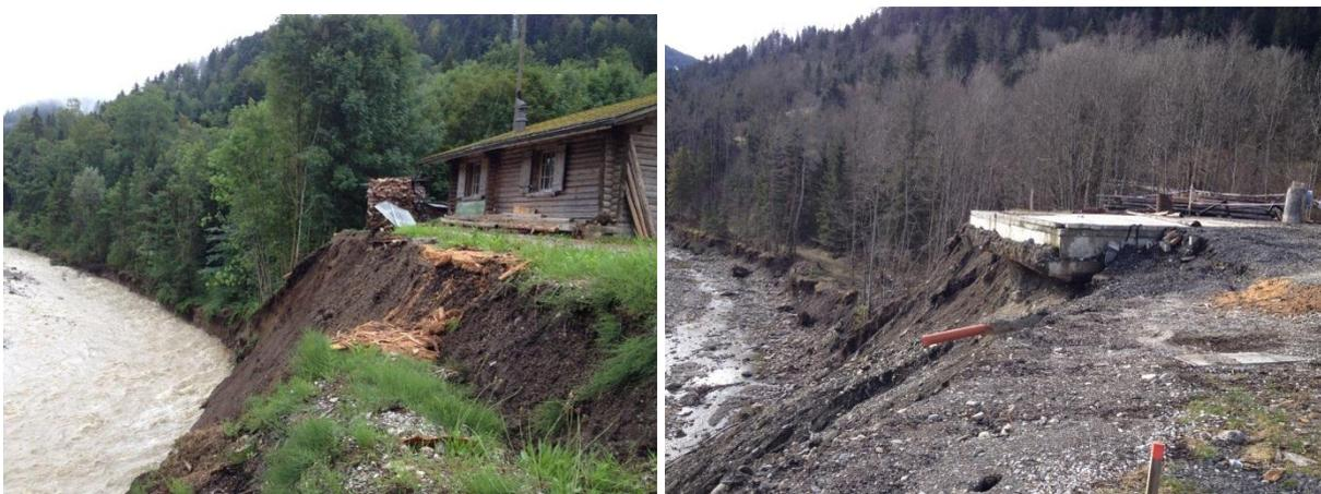
Figure 10 : Érosion des berges de la Singine (ancien remblai, photos durant les crues et avril 2015).
