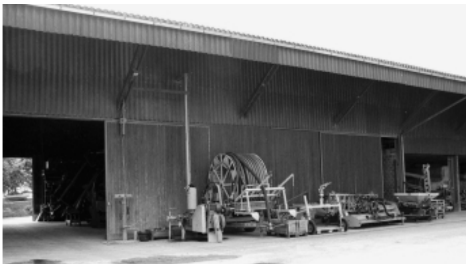
Fig. 8: Un avant-toit suffisamment grand offre un espace de rangement supplémentaire, notamment pour le stockage temporaire des machines et des outils.
