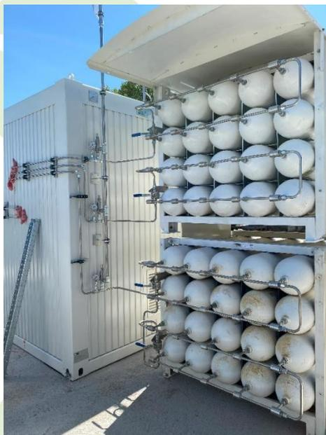
Réservoir de bouteilles de gaz haute pression pour station-service de biogaz
